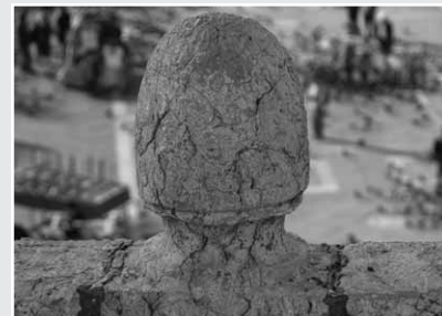
Die Balustradenelemente wurden mit flüssigem Blei verstärkt.
