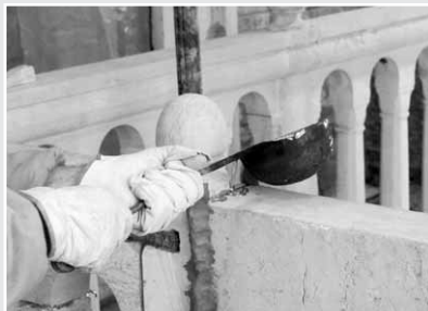
Die Balustradenelemente wurden mit flüssigem Blei verstärkt.
