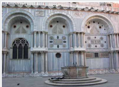
Restaurierte Fassade und Detail
