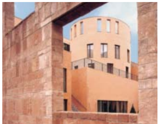
Massive Steine strahlen mehr aus als dünne Platten. In der indischen Botschaft in Berlin hat Hilde Léon roten indischen Sandstein in Verbindung mit farbigem Beton verbaut.
