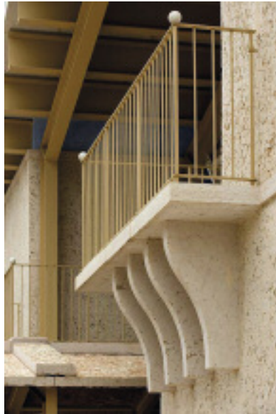
Balkon mit Stützelementen aus Pietra della Lessinia Fotos: Alexandra Becker
